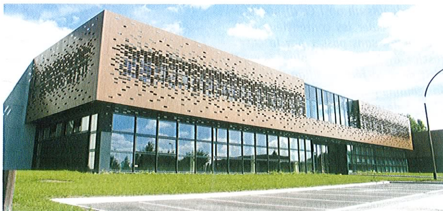
La pépinière d'entreprises de la Communauté de communes du Lunévillois, gérée par la société Sogequare, accueillera ses premiers locataires au mois de septembre sur le site du Pôle Lavoisier.
